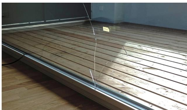
Sur les portes coulissantes en verres à isolation thermique et de protection solaire, un rayonnement direct du soleil peut provoquer un bouchon de chaleur entre les vitres superposées lorsque la porte est ouverte et entraîner ainsi un choc thermique. Ce même problème se retrouve souvent avec des rideaux ou des stores reflétant le rayonnement infrarouge et présentant une circulation d'air insuffisante.
