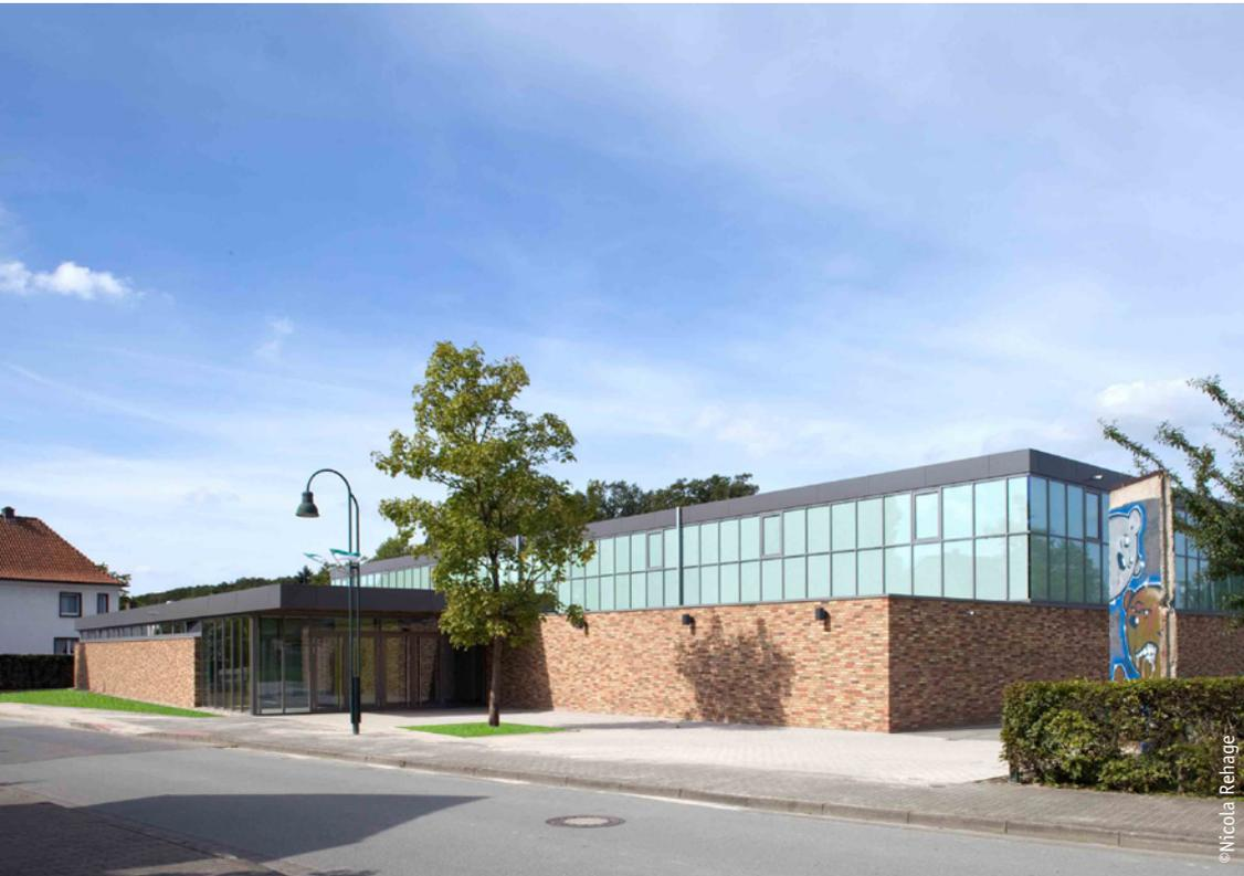
aus Kunststoffhohlfasern, die das einfallende Licht nach innen leiten und gleichmäßig verteilen. Die Kapillareinlagen minimieren auch die Wärmeeinstrahlung durch die Sonne und verhindern die Konvektion im Glas. Neben sinkenden Kühllasten im Gebäude verbessert sich dadurch der Ug-Wert der Fassade deutlich – wertvolle Energie wird gespart. Auch die gute Farbwiedergabe der Isolierverglasung ist in der Hans-Joachim-
